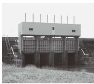
和食川水門排水ポンプ 設置工事状況
