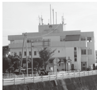
非構造部材耐震化対象施設 (芸西村役場庁舎)
