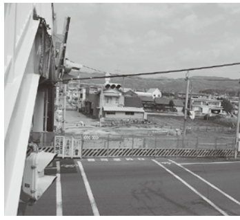
村道と食馬ノ上線 拡幅工事状況
