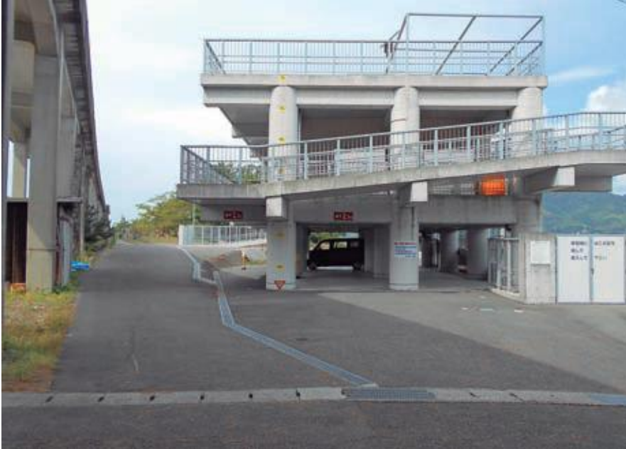
和食津波避難タワー
