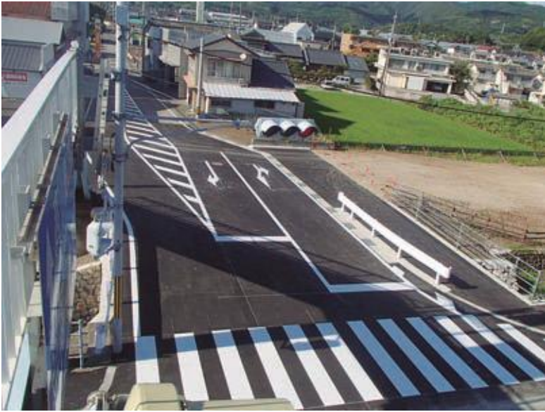
村道と食馬ノ上線拡幅工事完成
