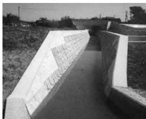
コモ谷川改修工事完成箇所
