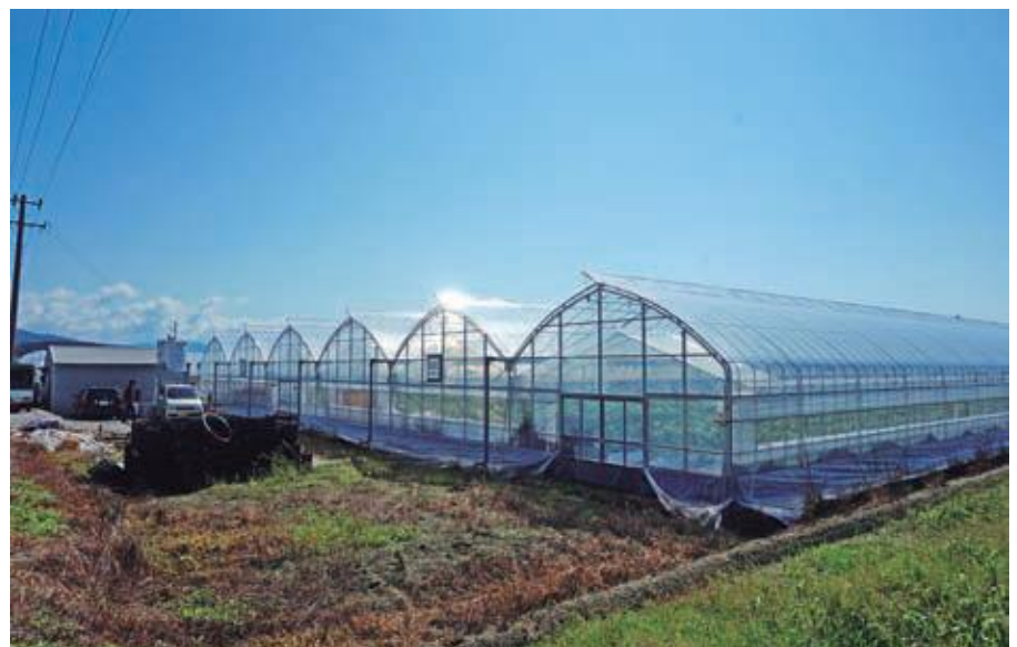
レンタルハウス（令和元年度施工）
