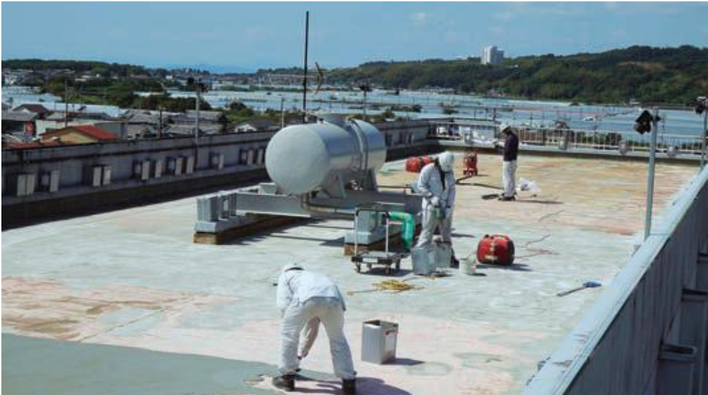
防水工事中の中学校屋上
