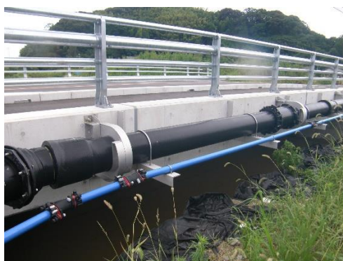
【ダクタイトル鉄管-NS形継手】
