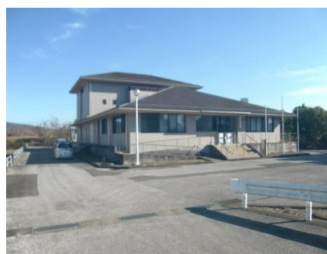
【浄化センター(管理棟)】
