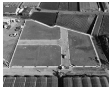
分譲用宅地造成工事
