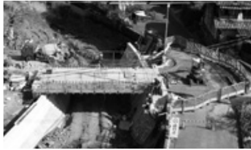
河川改修橋梁
