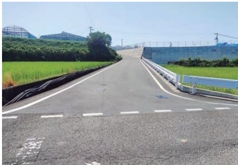
拡幅工事が完成した入野4号線
