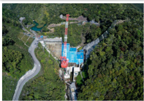
水源確保のため建設が続く和食ダム
