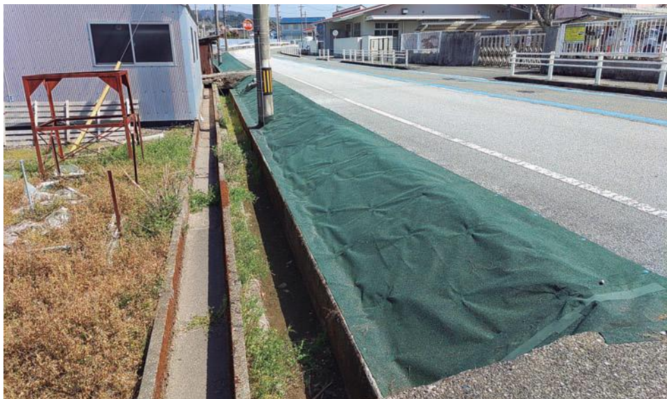
施工された防草シート
