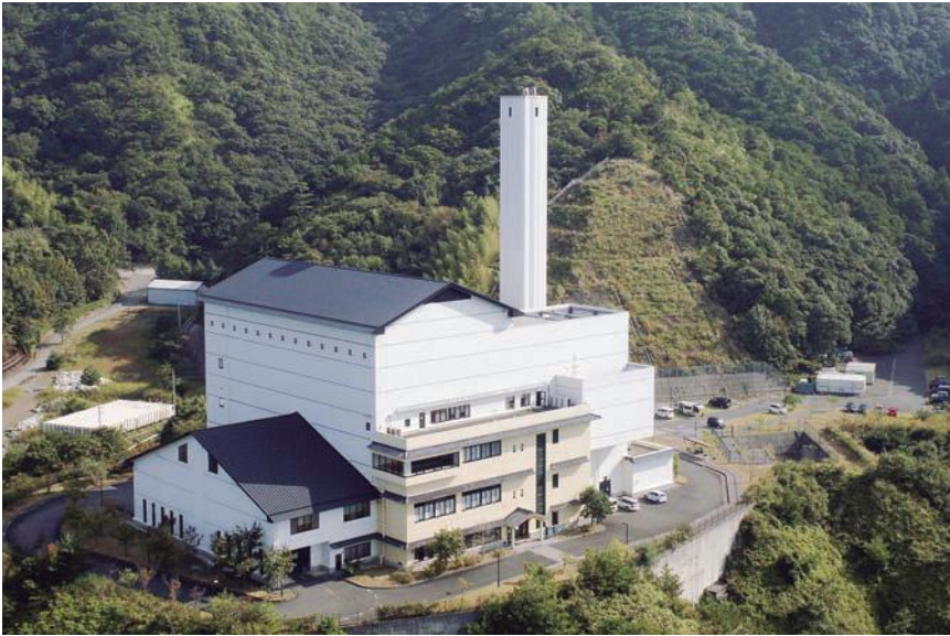
改修が予定される安芸メルトセンター
