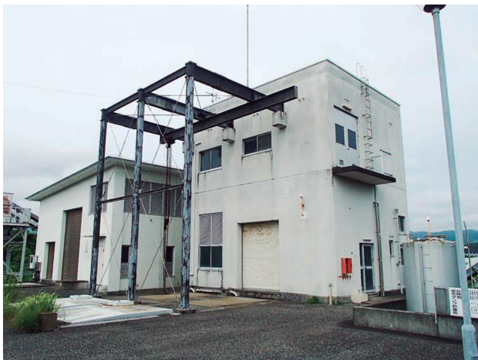
改修工事が予定される和食排水機場
