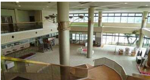
③1F天井 天井の落下等は発生していないか
