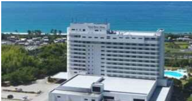
①外壁 外壁の落下、窓ガラスの割れはないか
