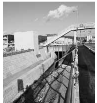
和食陸橋東側の江渡川護岸の様子
